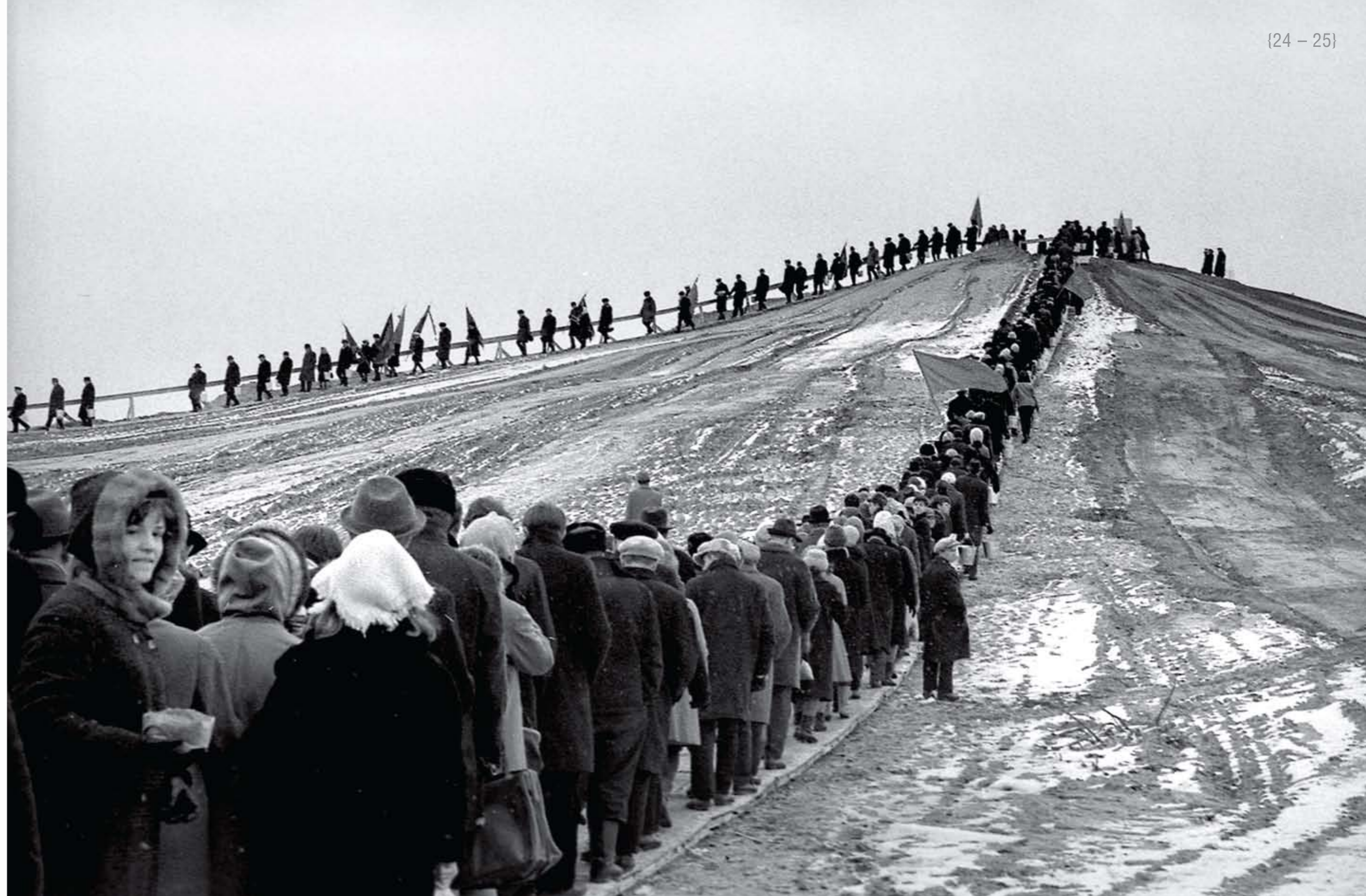
Засыпка Кургана Славы – зямлю везлі з усіх месцаў, звязаных з подзвігам народа ў гады Вялікай Айчыннай вайны. 20 верасня 1967 г. Засыпка Кургана Славы – землю везли со всех мест, связанных с подвигом народа в годы Великой Отечественной войны. 20 сентября 1967 г. The soil that the memorial is made of was brought from all the places associated with the feat of the nation during the Great Patriotic War, 20 September 1967
