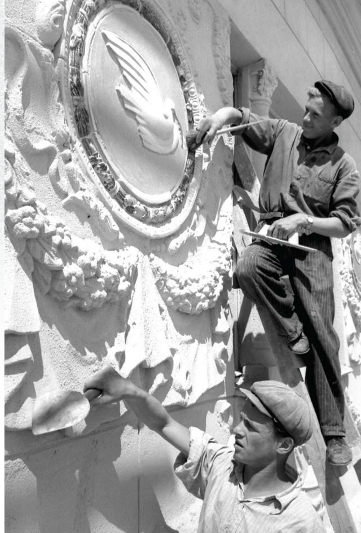
Адзелка фасада дома на Круглай плошчы ў Мінску. 17 чэрвеня 1954 г. Отделка фасада дома на Круглой площади в Минске. 17 июня 1954 г. Finishing of the facade of a house in Kruglaya Square in Minsk, 17 June 1954
