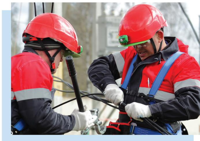
Электромонтеры выполняют монтаж изолированного провода
