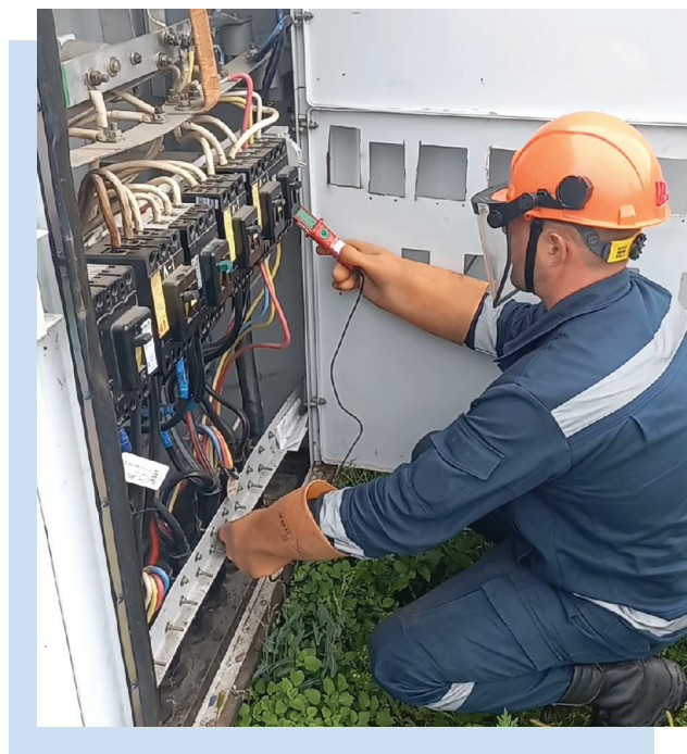
Установка столбовой трансформаторной подстанции
