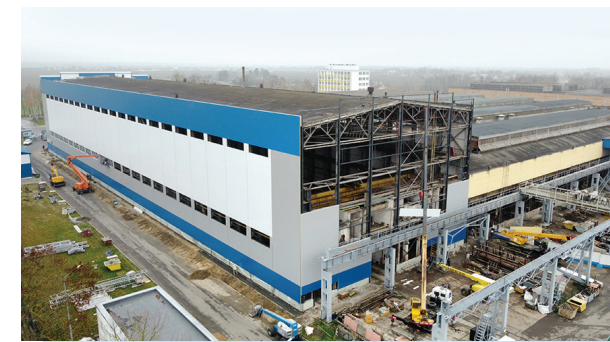
В филиале «Белоозерскэнергоремонт» активными темпами идет реконструкция производственного помещения № 1
