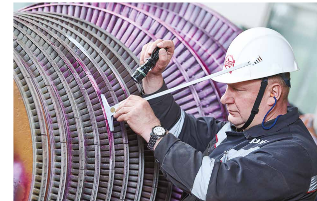
Ремонт турбинного оборудования
