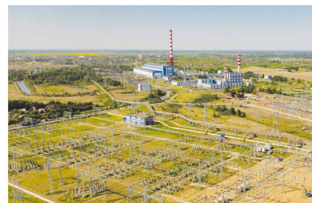
Строительство пиково-резервного источника на Березовской ГРЭС
