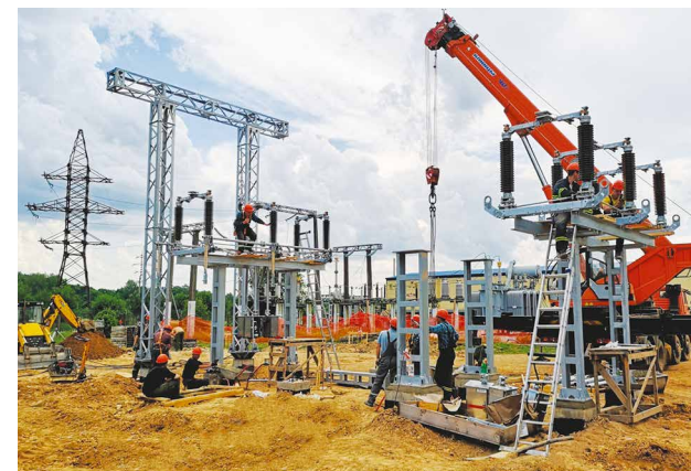
Реконструкция подстанции 110/35/10/6 кВ «Болбасово»
