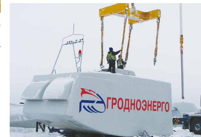
Возведение ветропарка в Новогрудском районе
