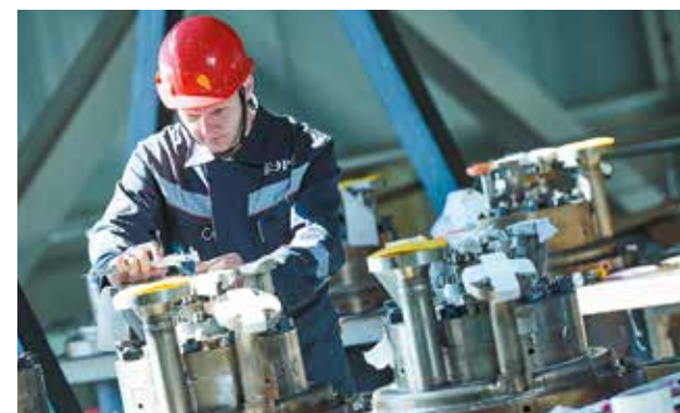
Сервисное обслуживание газотурбинного оборудования
