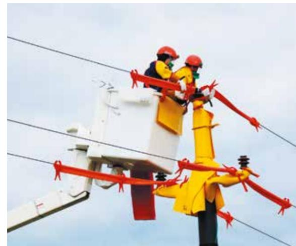
Выполнение работ под напряжением 10 кВ по замене опоры
