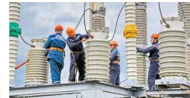
Ремонт высоковольтного оборудования на подстанции
