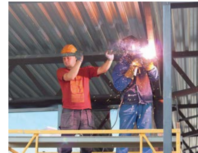
Строим промышленные здания и сооружения
