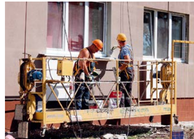
Возведение жилья и его капитальный ремонт – важное направление деятельности ОАО «Стройтрест № 2»
