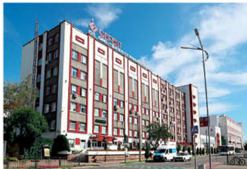
Главный корпус СП ОАО «Брестгазоаппарат»
